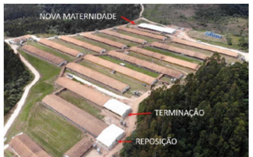
Vista aérea da Unidade de Produção de Leitões que, com as reformas, passa a ter capacidade de 5,7 mil criadeiras
